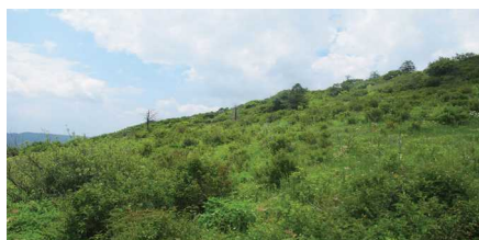
〈폐군사시설 복원 후〉
